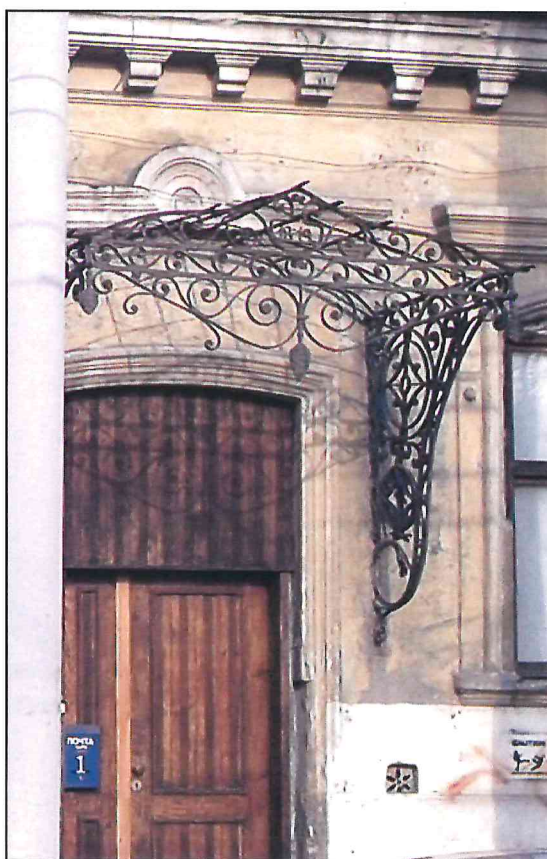
10. Фрагмент парадного южного фасада литера А Объекта. Козырек парадного входа. Фото 2010 г.
