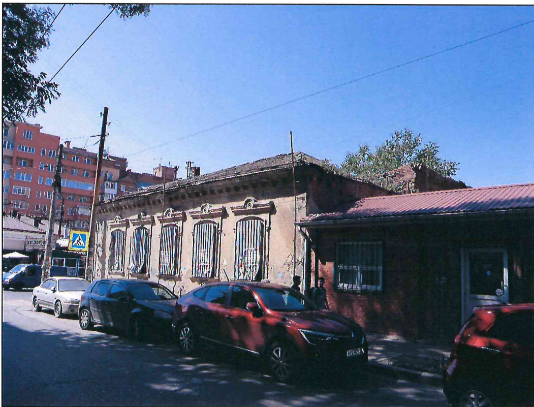
5. Вид литеры А Объекта с северо-востока. Фото 2024 г.
