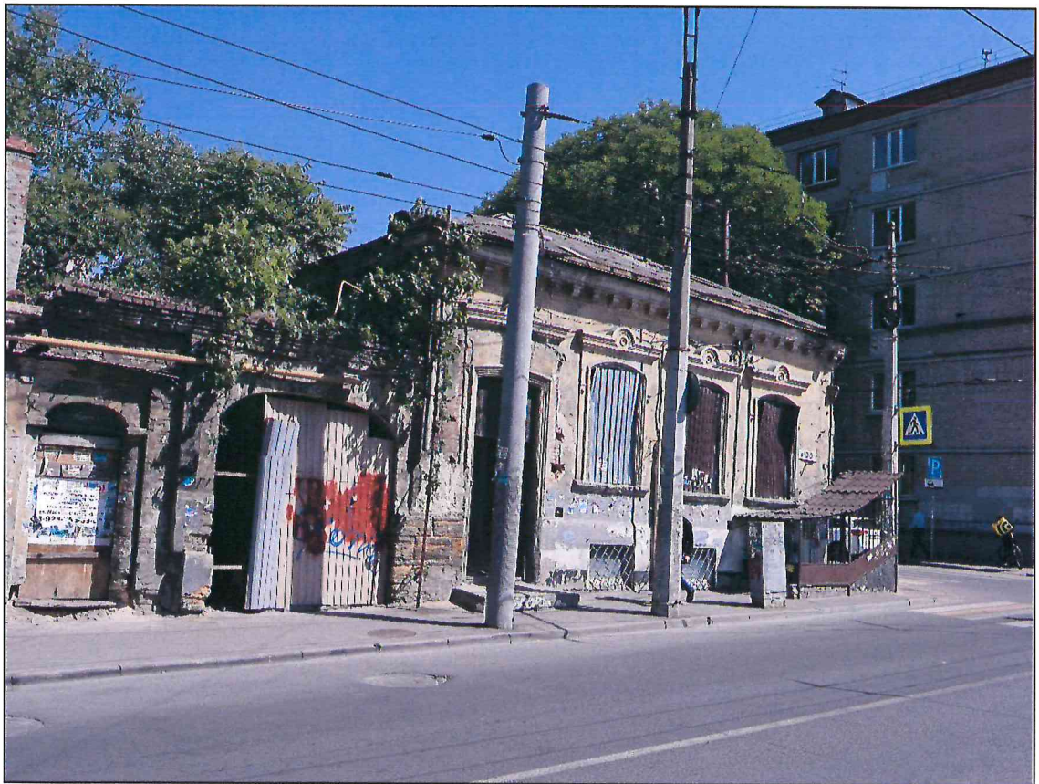
4. Вид литеры А Объекта с юго-запада. Фото 2024 г.
