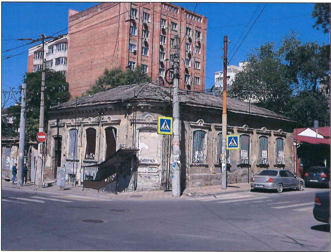
3. Вид литеры А Объекта с юго-востока. Фото 2024 г.
