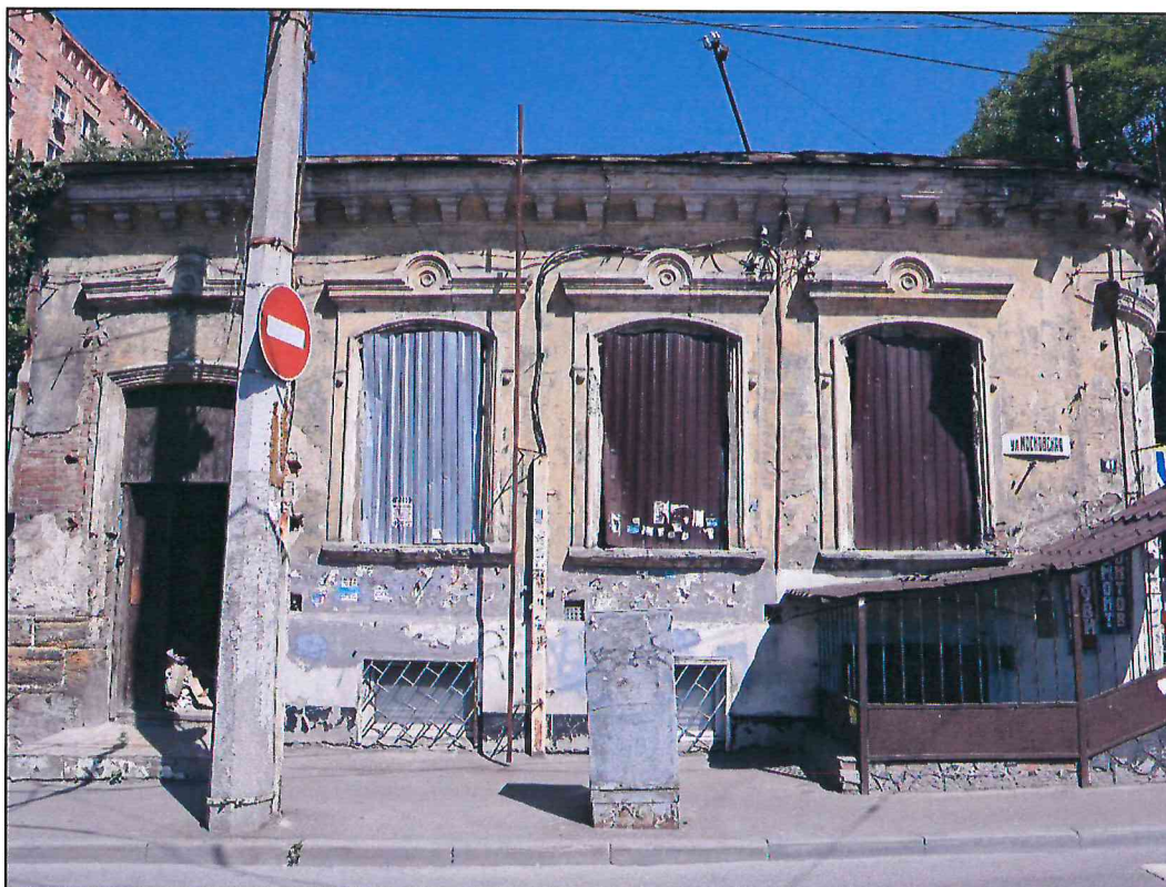
6. Парадный южный фасад литеры А Объекта. Фото 2024 г.
